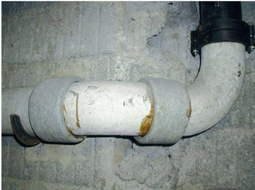
Condutture in cemento-amianto
