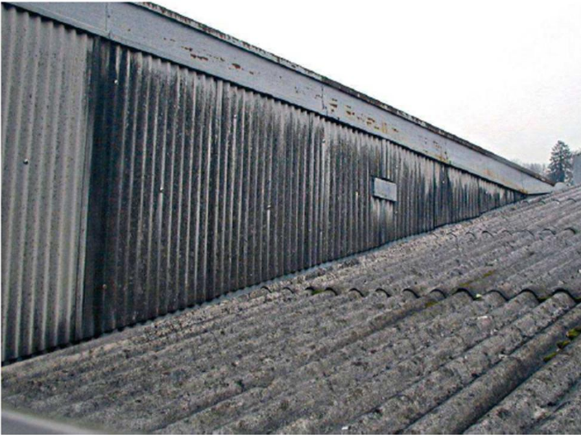
Lastre di copertura in cemento-amianto
