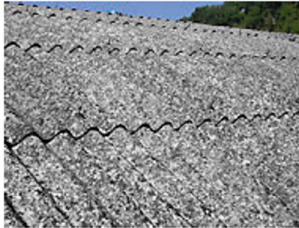
Lastre di copertura
