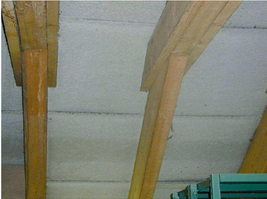
Isolamento del tetto con lastre in cemento-
